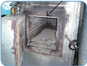
Cordón de amianto que sela a porta 2
