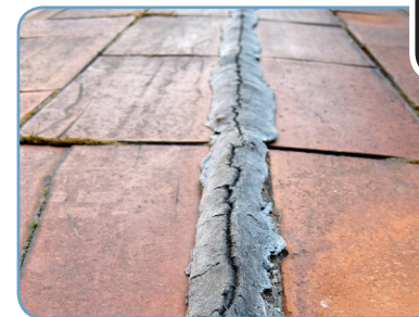
Masilla en xunta de dilatación
