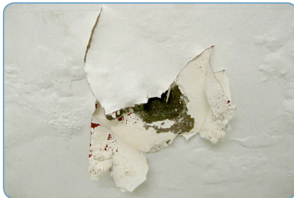
Pintura con amianto
