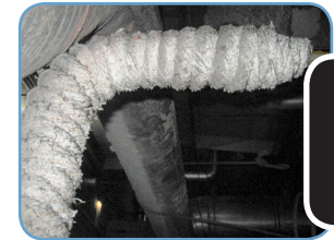
Corda trenzada (calorifugado)
