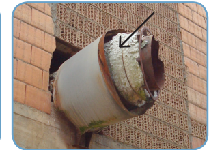
Calorifugado en conduto de evacuación de fumes industriais
