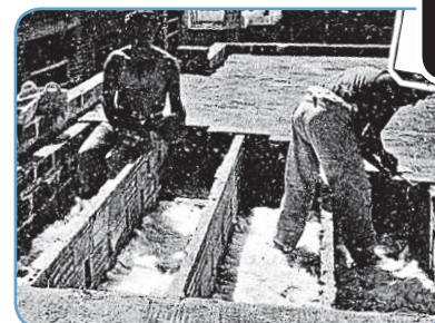
Amianto solto en cámara de cuberta 1
