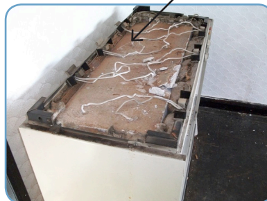
Amianto solto no interior dun radiador
