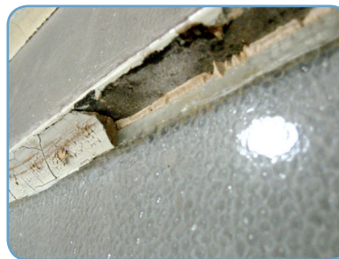
Masilla selante en unión (ventá)
