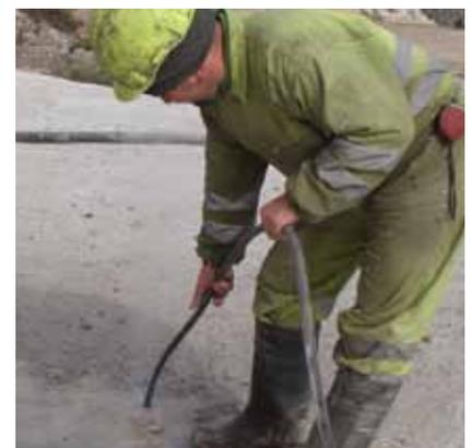
Comprueba la profundidad y limpieza de los barrenos que se van a cargar.
