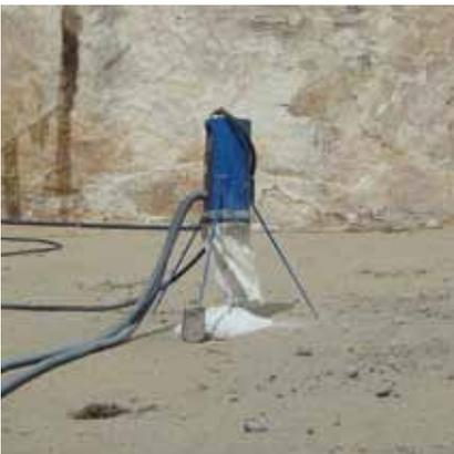
Comprueba el buen funcionamiento de los capturadores de polvo. Procura colocarte de manera que la trayectoria del polvo no pase por tu zona de respiración.
