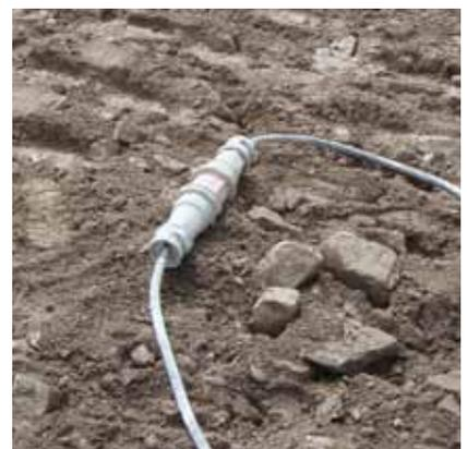
Emplea conexiones preparadas para la intemperie. No las dejes tiradas por el suelo. Nunca puede haber cables pelados.
