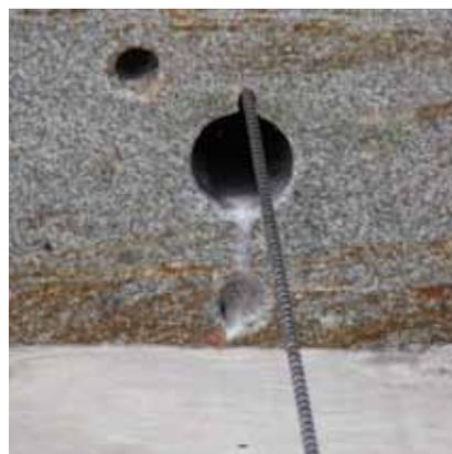
Comprueba que tienes agua suficiente para refrigerar el hilo. Cuando avances con las mangueras por la hendidura, detén la máquina.
